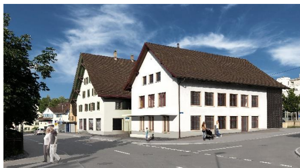
Ansicht von Usterstrasse SBB-Überführung, Blick Richtung «Rössli-Kreisel»
