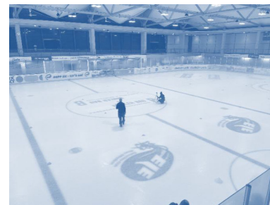
Neue Beleuchtung während Lichtmessung
