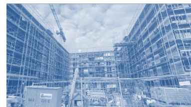
Rütlihof; Foto vom Innerhof während dem Bau www.ruetlihof.ch
