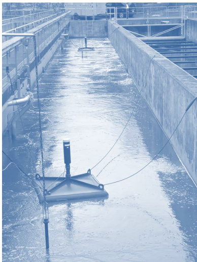
Ablufthauben der Lachgasmesskampagne
